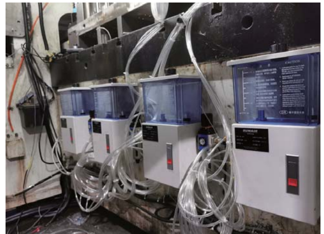
带微量泵系统 新能源电池外壳冲压
